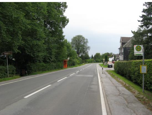
Achtung: Hier fehlt eine Überquerungshilfe!
